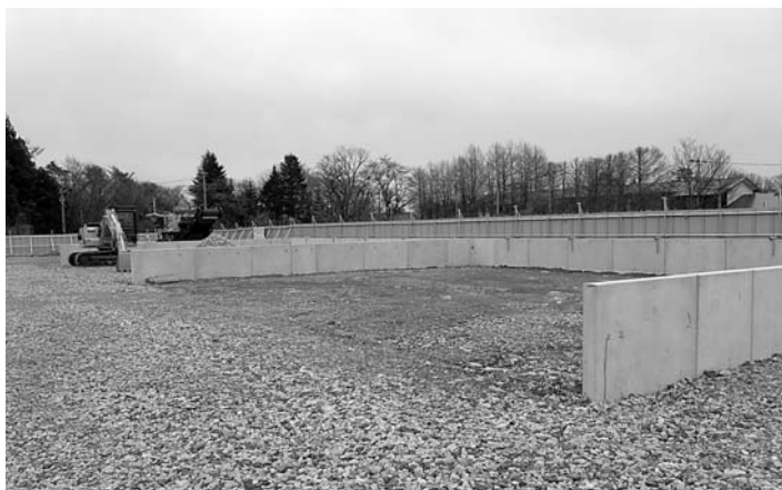
ガラパゴスで加工した砕石は、雑割石と RC-40 が混ざらないように、コンクリート壁で仕切った状態で保管される
