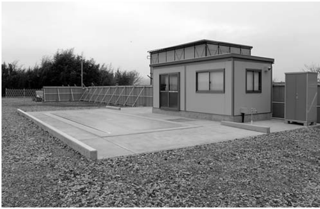
受付前のトラックスケールは最大 10 トン車まで計測可能。持ち込まれた産廃の荷下ろし前後の重量を計測することで引き取った量を計算する
